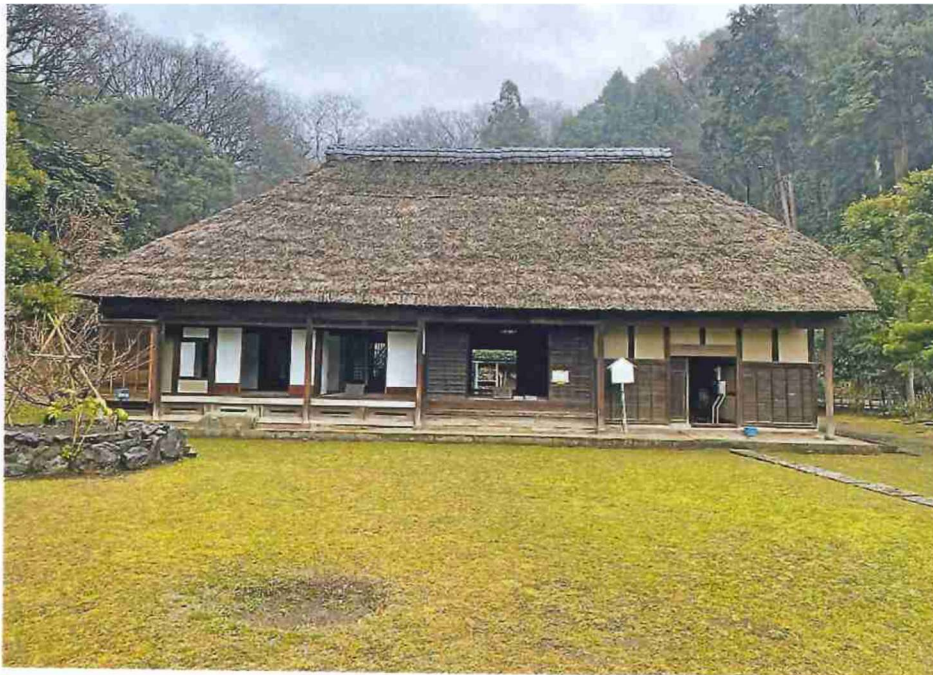
旧小池邸 正面 外観 茅葺屋根 屋根替えが必要 昨年より傷みが進んでいます
