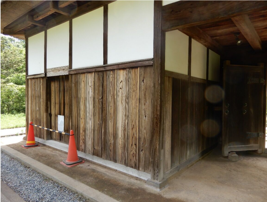
旧福原家長屋門 東間背面扉口
