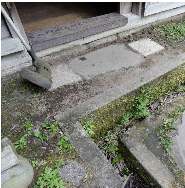
背面出入口 雨落ち溝
