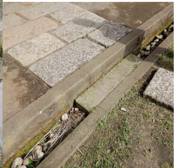
正面出入口（大戸口）前の雨落ち溝
