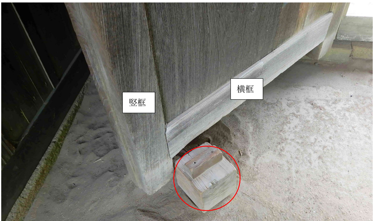
旧福原家長屋門 通路扉 扉足元の受木らしい部材 (○印)
