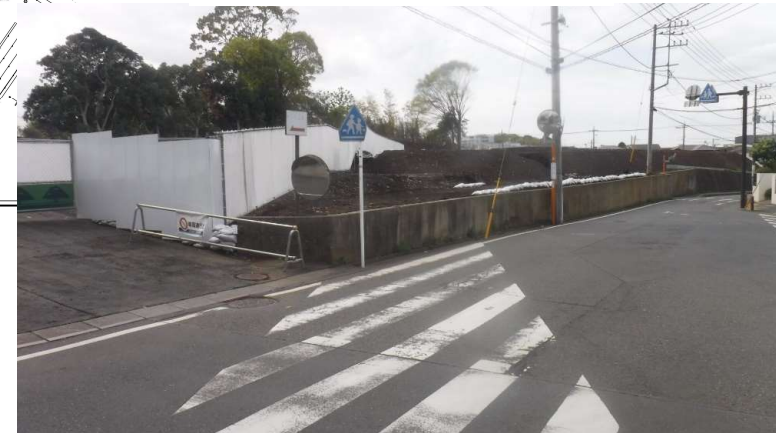
【②北側擁壁撤去】
