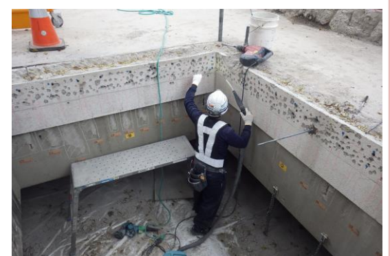
サンパール広場増床のための工事の様子（2018年2月）
