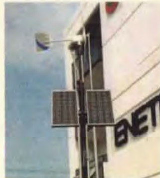
ローコストハイブリッド発電システム(風力、太陽光)
