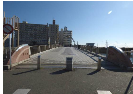
弁天橋（境川）【高欄・橋面改修工事等】
