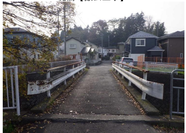
境橋【撤去工事】
