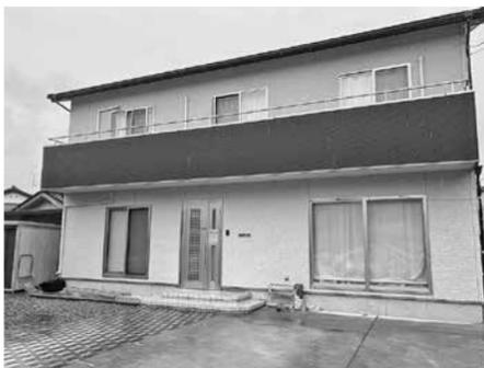
旧耐震基準の住宅は倒壊など大きな被害を受けましたが、すぐ近くにある新耐震基準の住宅(左記の写真)に目立った被害はありませんでした。
